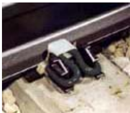
Obrázek 2: Upevnění Pandrol Fasclip [6]:
